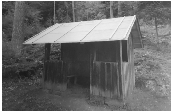
Die Hütte nach den Sanierungsmaßnahmen
